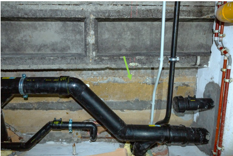
Figuur 53: Voorbeeld van platen type "Menuiserite" als verloren bekisting aan betonnen plafond
