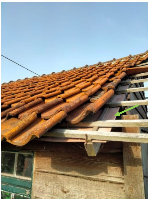
Figuur 54: Voorbeeld van niet-eenvoudig bereikbare onderdakplaten
