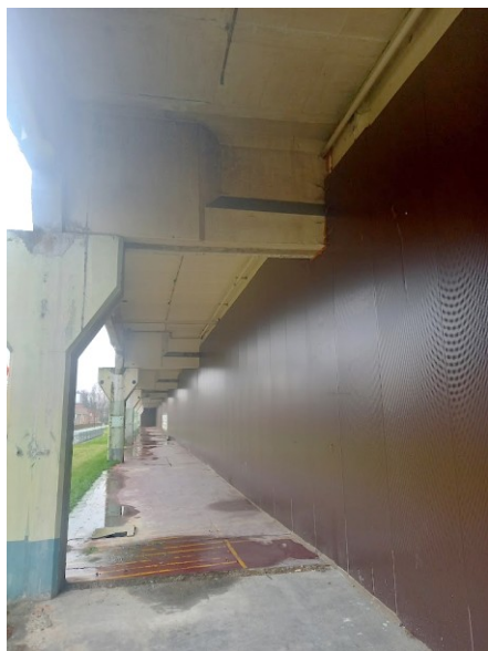
Figuur 55: Voorbeeld van niet fysiek bereikbaar plafond (> 3,50 m)
