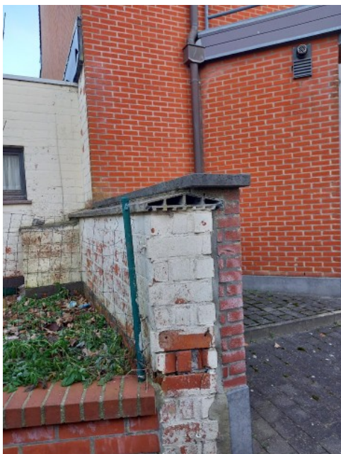
Figuur 68: Voorbeeld van een asbestverdachte (links) en niet-asbestverdachte (rechts) deksteen
