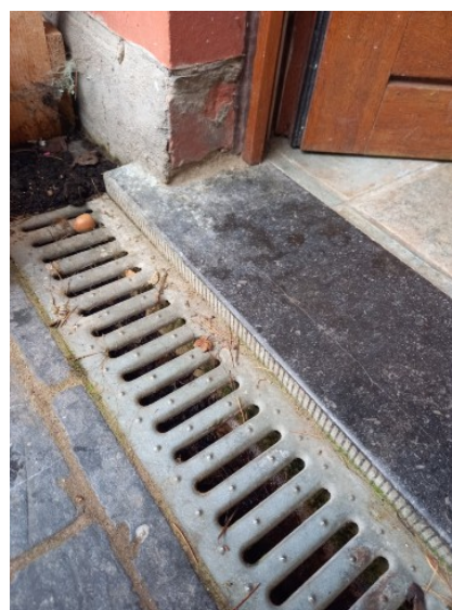
Figuur 4: Voorbeeld van een waarneembare ruimte onder losliggend rooster.
