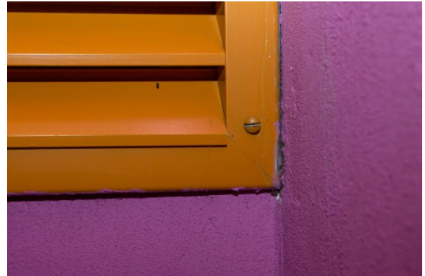
Figuur 6: Voorbeeld van waarneembare ruimte achter dichtgeschroefd rooster als de ADI die ruimte visueel kan onderzoeken met een zaklamp via de bestaande spleten. De ADI moet het rooster daarvoor niet demonteren.
