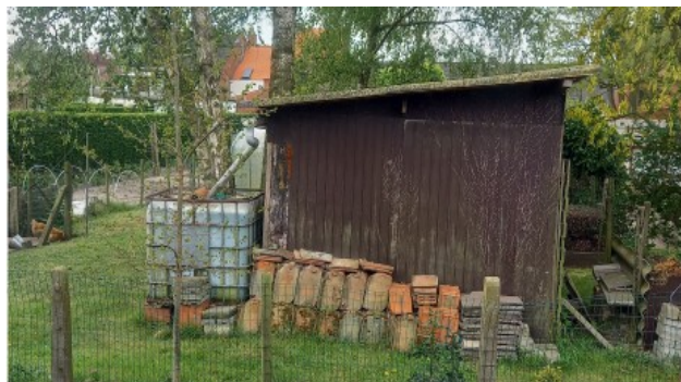
Figuur 45: Voorbeeld van golfplaten als dakbedekking en bijhorende regenwateropvang
