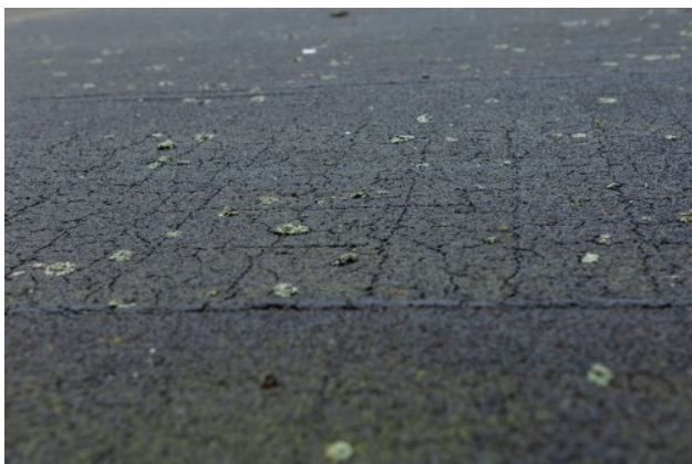
Figuur 41: Voorbeeld van roofing met bitumen afkitlaag
