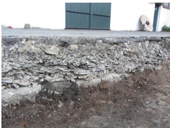
Figuur 1: Voorbeeld van ophooglaag met stukken vezelcement die in normale omstandigheden niet waarneembaar is.
