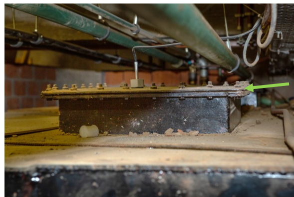
Figuur 61: Voorbeeld van een mangatdeksel van een stookolietank, met mogelijke dichting type "Klingerit"
