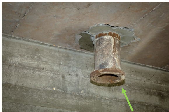
Figuur 60: Voorbeeld van beige resten van een flensdichting type "Klingerit"
