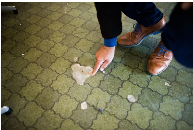
Figuur 49: Voorbeeld van vinylvloer met onderlaag in asbestkarton
